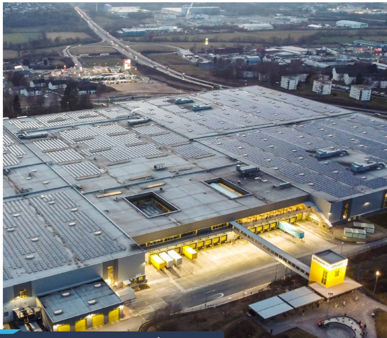
CENTRE LOGISTIQUE AMAZON ALLEMAGNE À BAD HERSFELD
